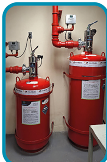
Sistema de supressão – Obras Raras – Lâmina III
