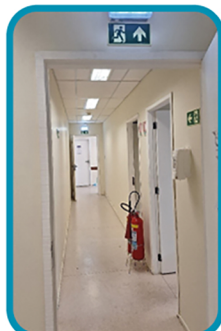
Sinalização de orientação e salvamento, Sinalização de equipamentos e Iluminação de emergência – Juizado do torcedor Engenheiro
