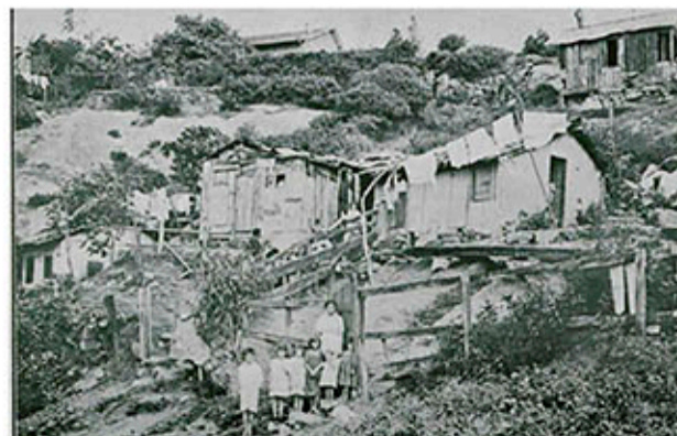
MORRO DE S. CARLOS. — Neste local não houve socorro aos moradores.
