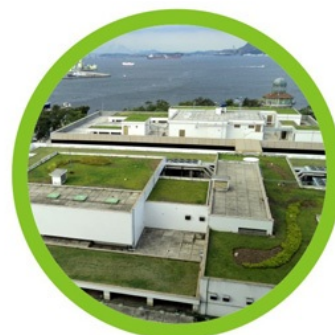
Telhado Verde na Lâmina III
