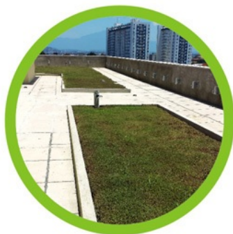
Telhado Verde no Fórum de Nilópolis
