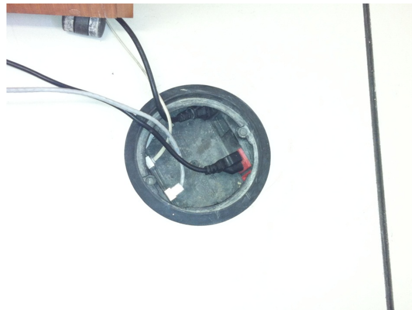
READEQUAÇÃO / PISO ELEVADO
